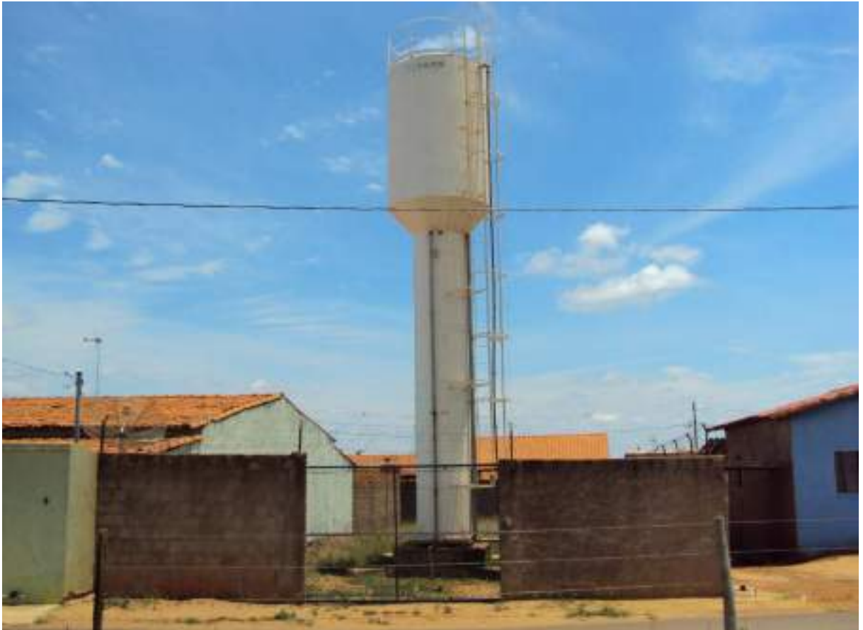
Foto: Reservatório elevado do Povoado de Celso Bueno.
