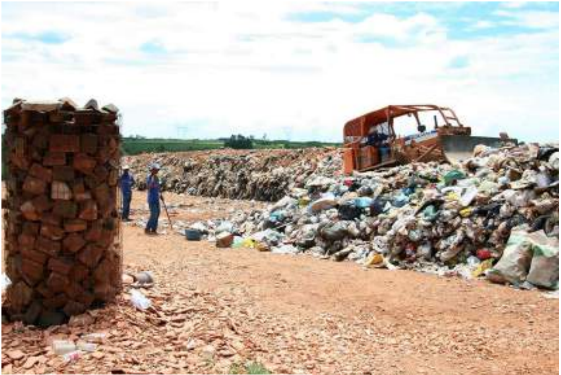
Foto: Compactação do Lixo no Aterro Sanitário
