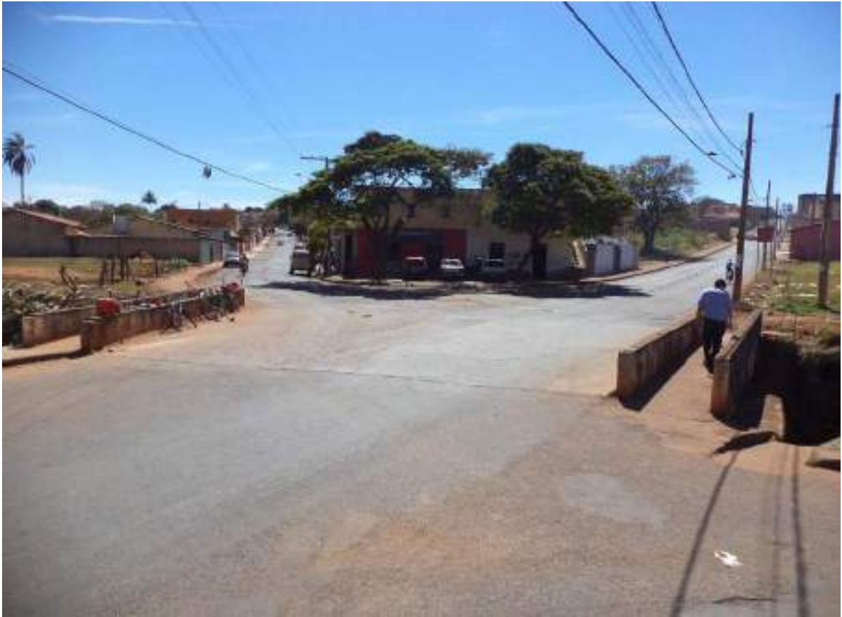
Foto: Ponto de alagamento, travessia sob Córrego Mumbuca, Rua Alferes Euzébio.
