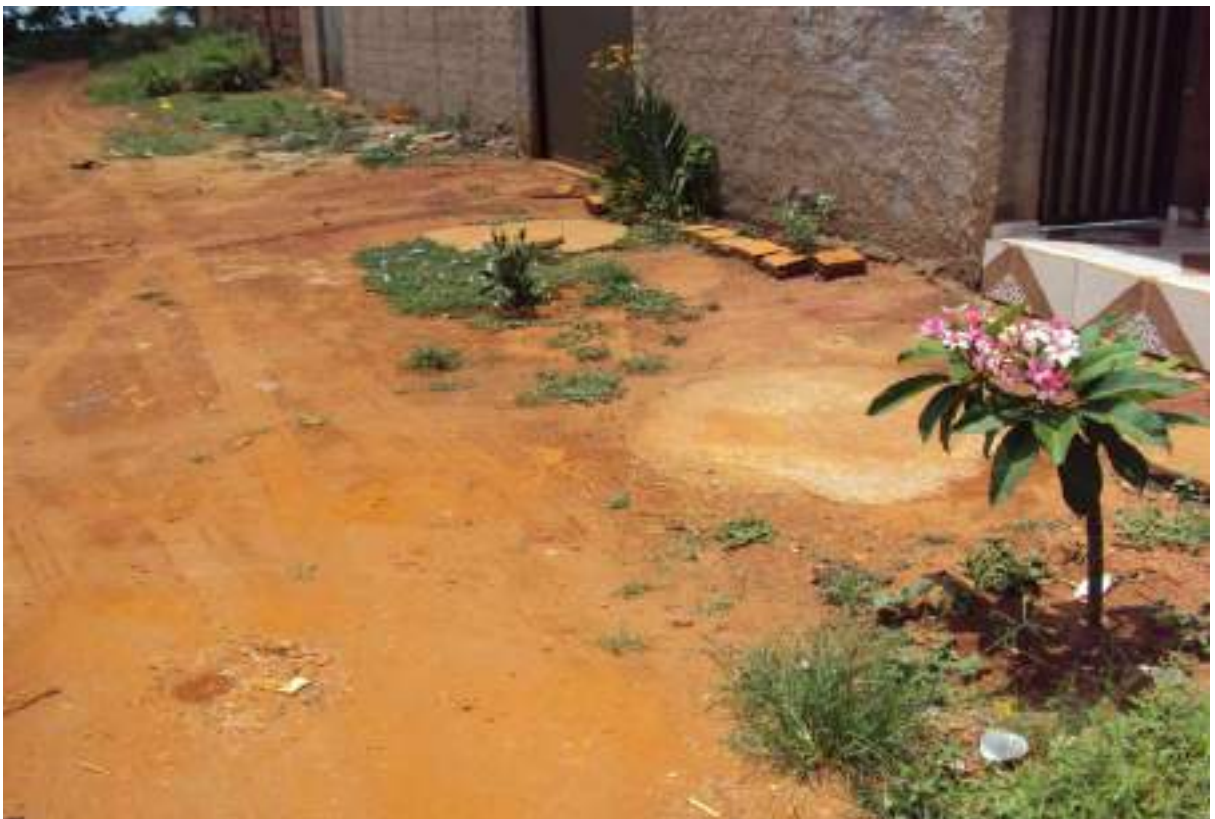
Foto: Fossa Negra em logradouro público no Bairro Mansões Fidalgo.
