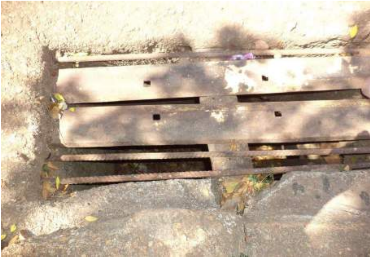
Foto: Boca de lobo no Bairro do Carmo.
