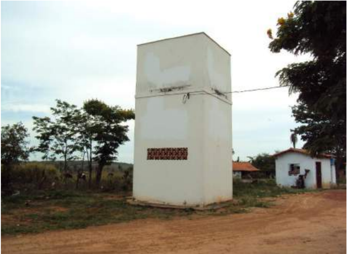
Foto: Reservatório elevado do Povoado dos Perdizes.
