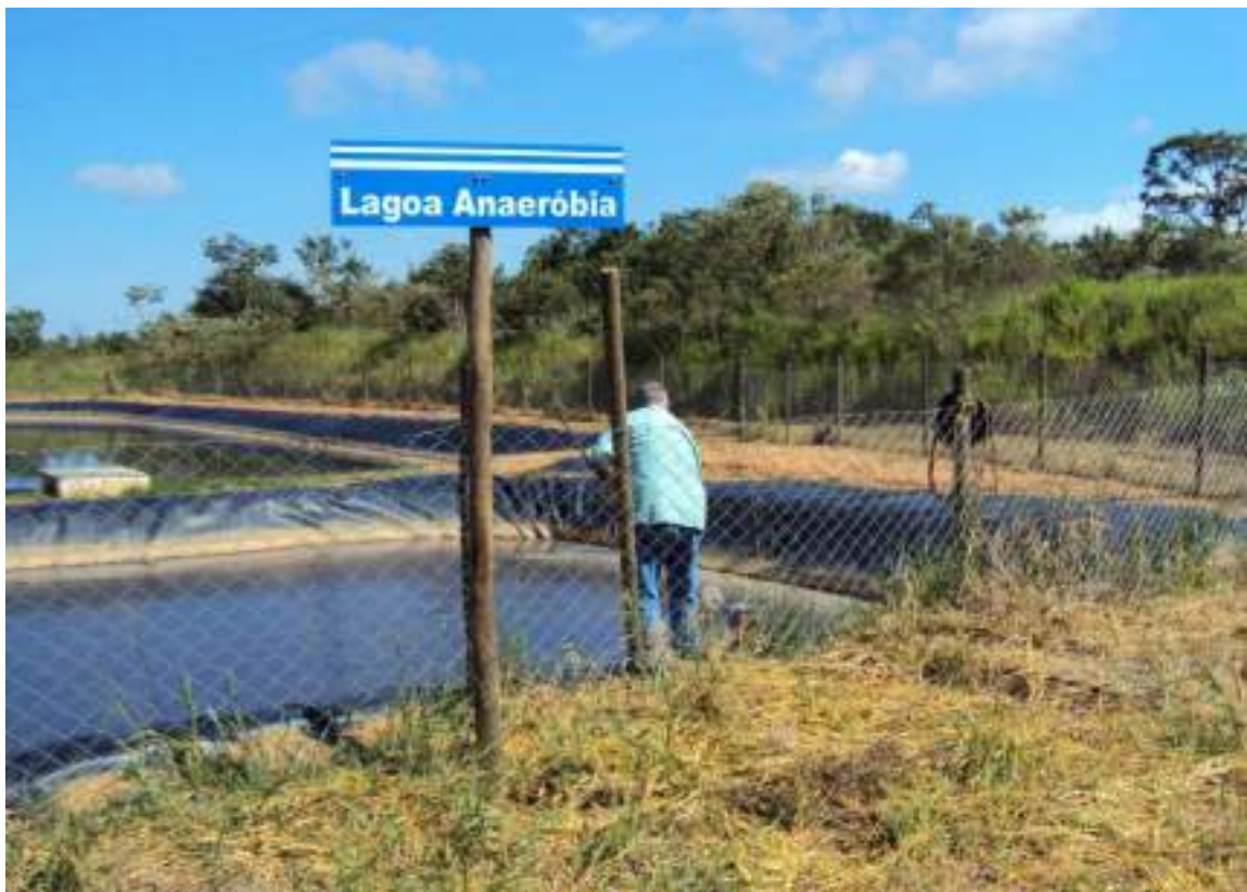
Foto: Lagoa Anaeróbica do Aterro Sanitário
