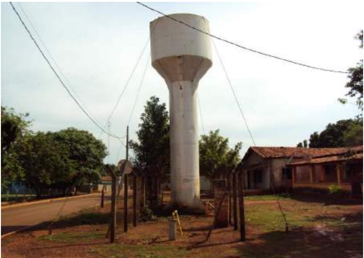
Foto: Reservatório do Povoado dos Gonçalves.
