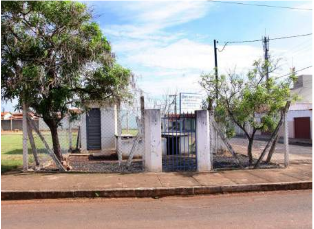
Foto: Poço profundo Morada Nova I (P9), devidamente protegido com cerca e larje de concreto.
