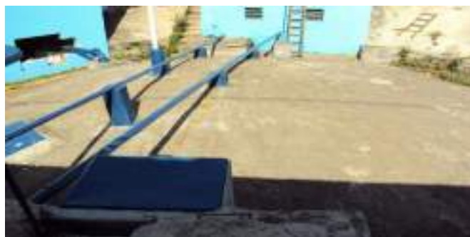
Foto: Reservatório enterrado (R3)
