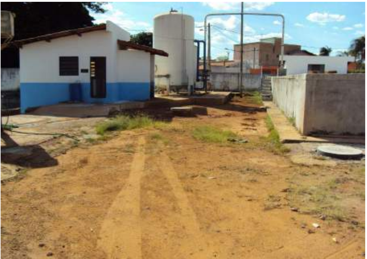
Foto: Estação elevatória de água tratada da ETA Lambari.
