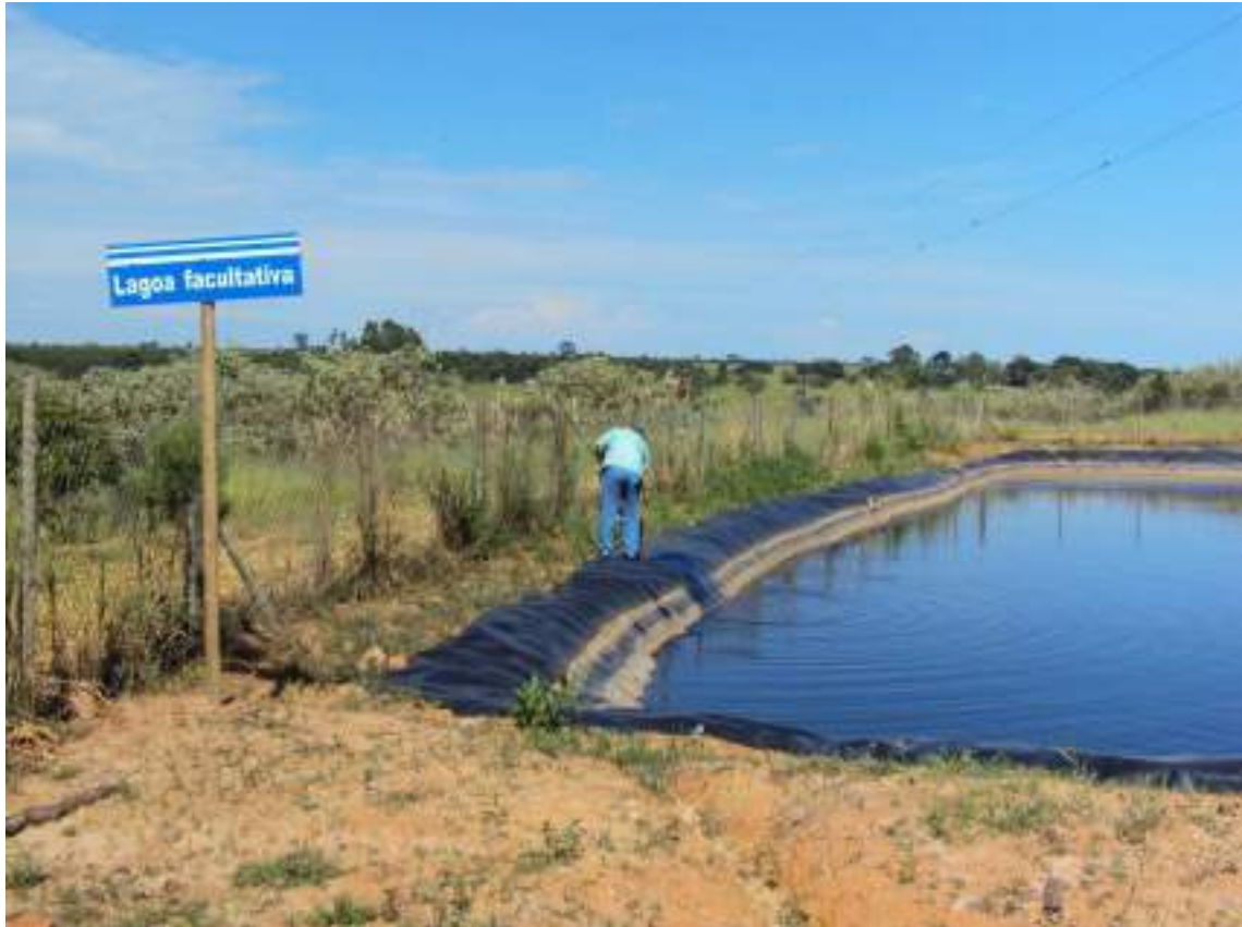
Foto: Lagoa Facultativa no Aterro Sanitário
