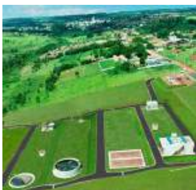
Foto: Vista aérea da ETE
