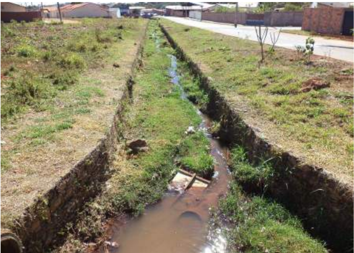
Foto: Trecho canalizado a céu aberto do Córrego Mumbuca.
