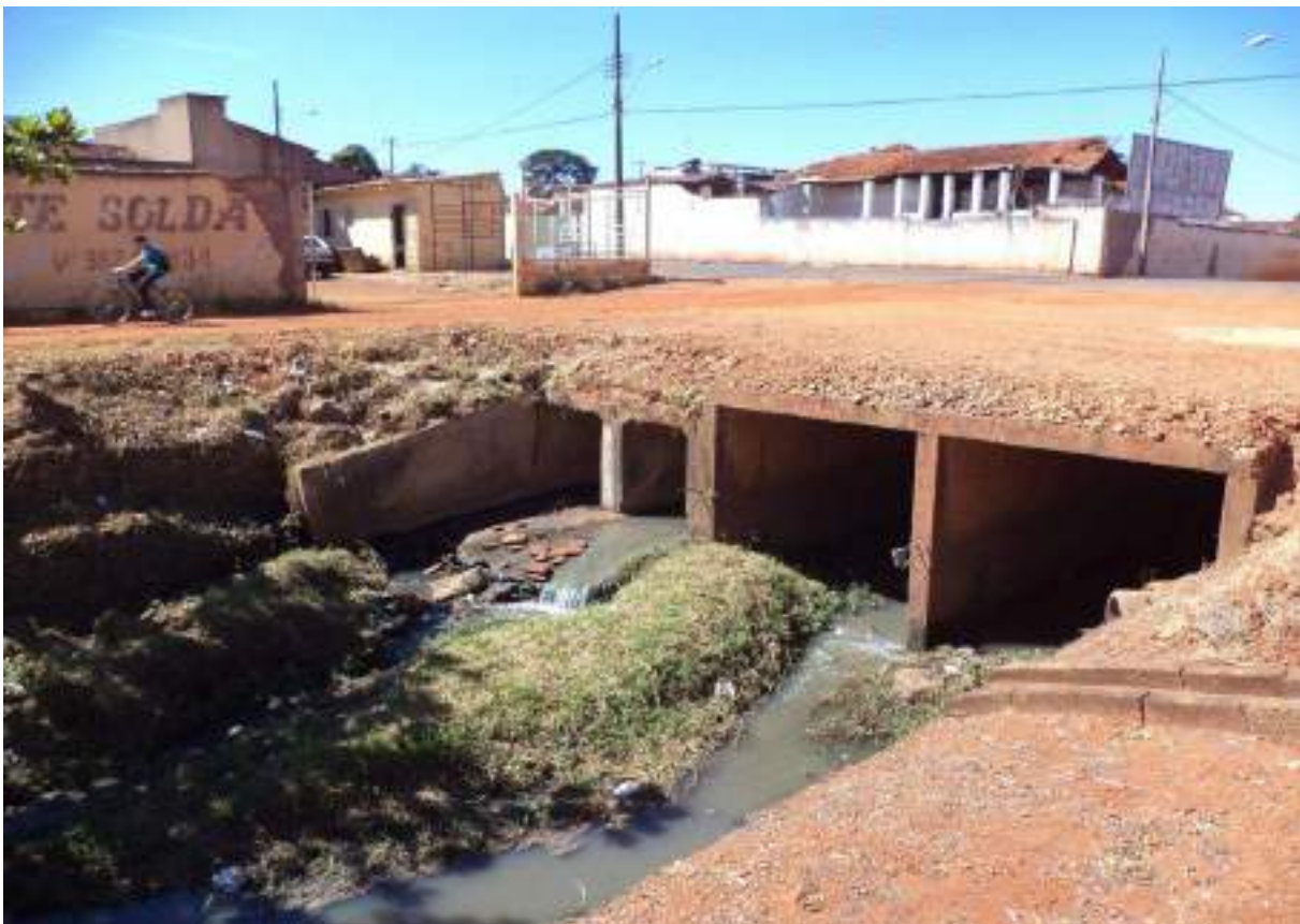
Foto: Travessia da rua José Avelino sob o Córrego Mumbuca.
