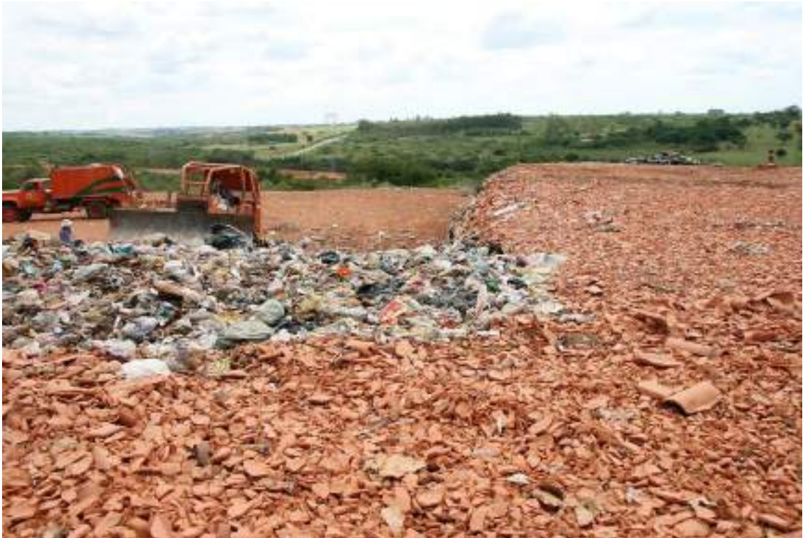
Foto: Cobrimento do Lixo com Cacos de Telha no Aterro Sanitário
