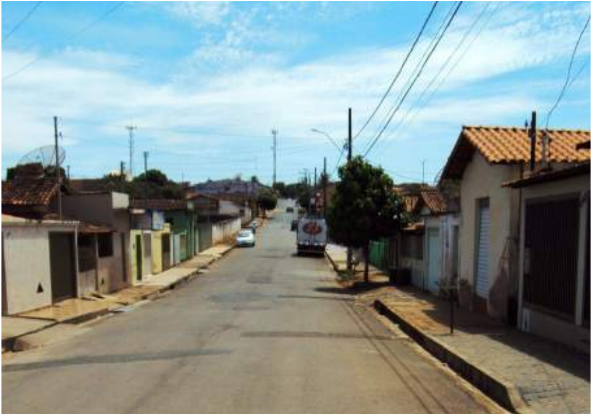
Foto: Ponto de alagamento, Rua Ceará, Bairro Vila Nova.
