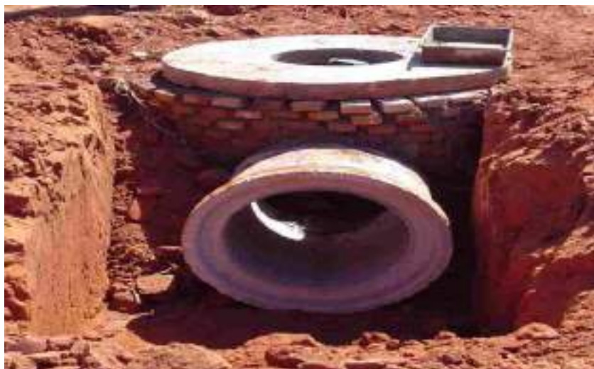
Foto: Construção da rede pluvial.
