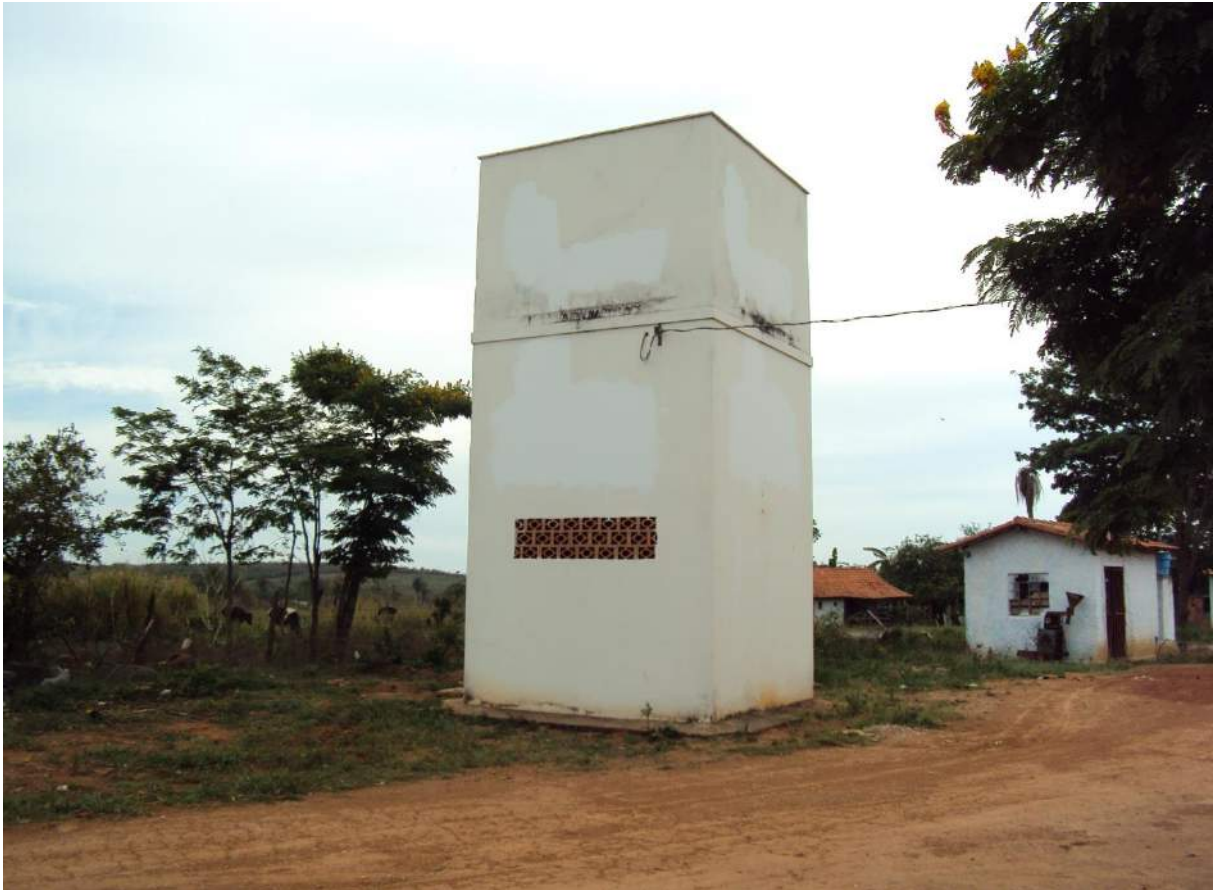
Foto: Reservatório elevado do Povoado dos Perdizes.
