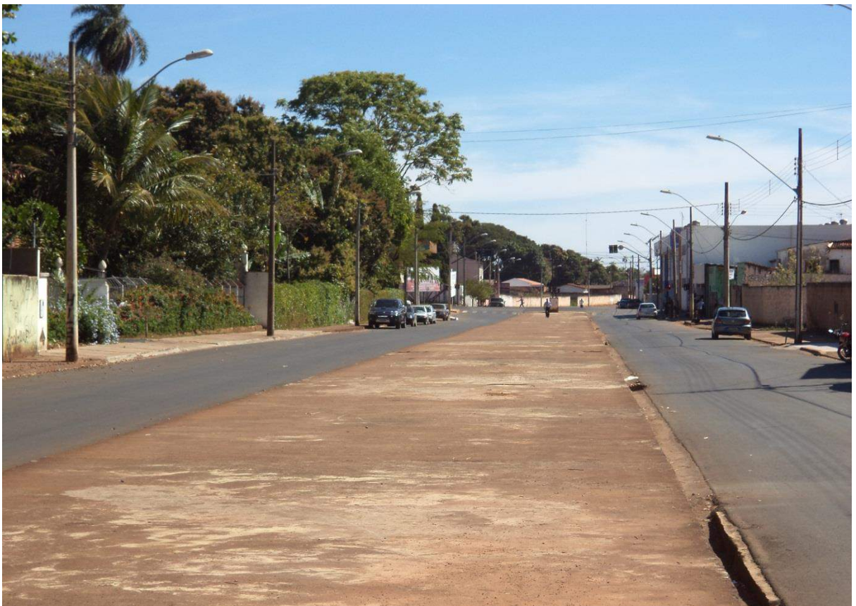
Foto: Trecho do Córrego Mumbuca canalizado com galeria de concreto.
