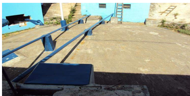
Foto: Reservatório enterrado (R3)
