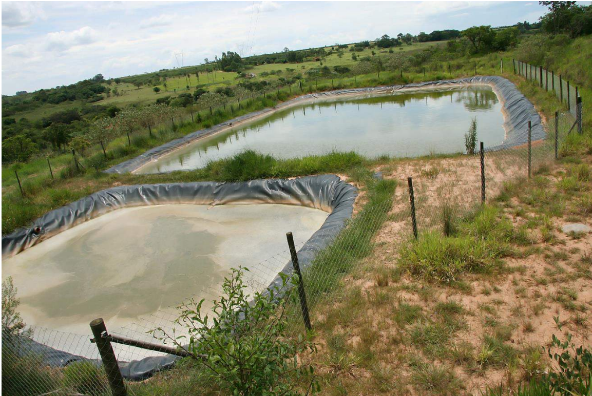
Foto: Lagoa Anaeróbica e Lagoa Facultativado Aterro Sanitário
