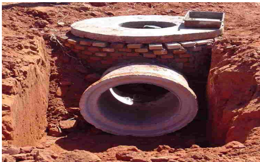
Foto: Construção da rede pluvial.
