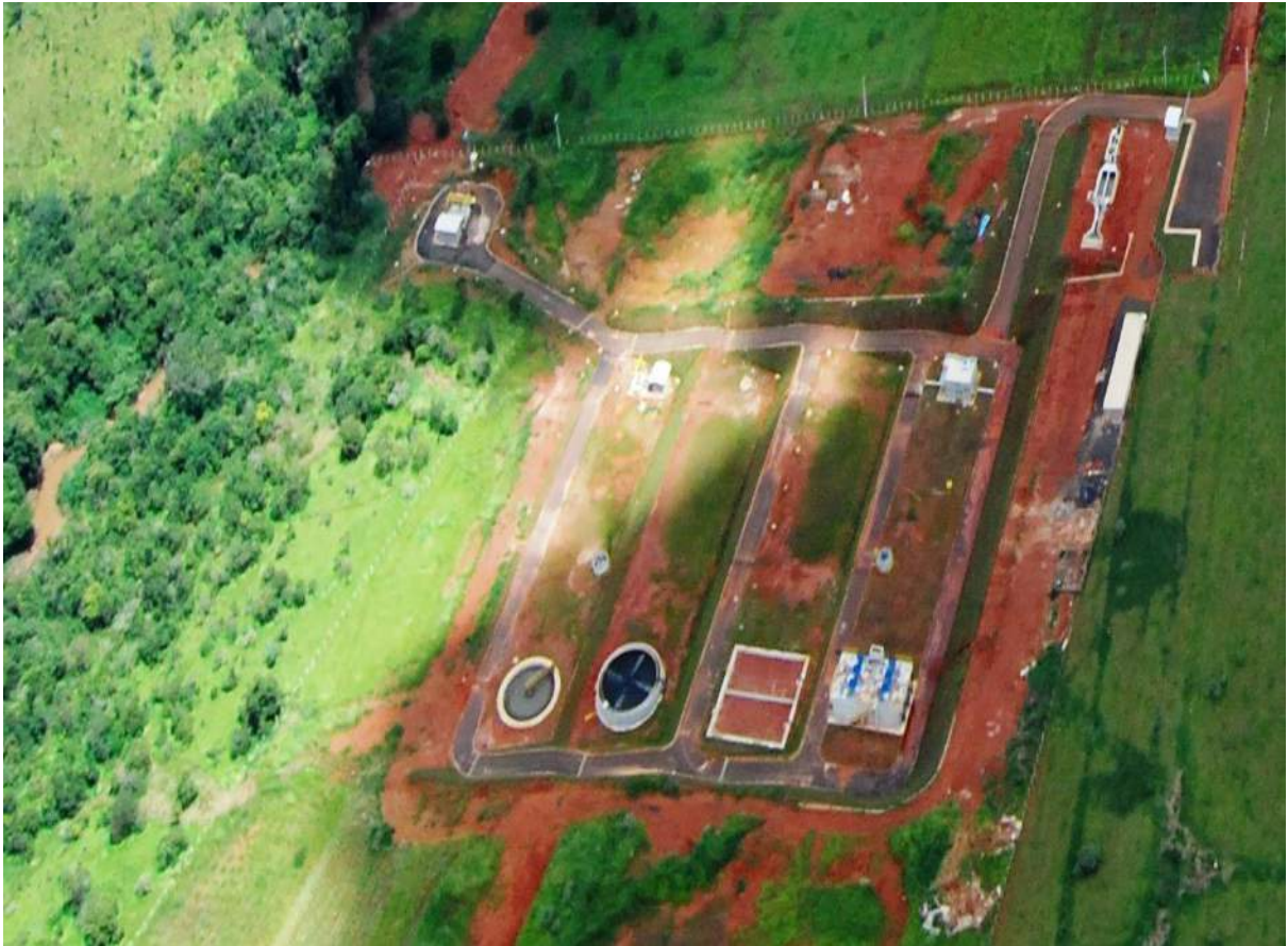
Foto: Vista aérea da ETE de Monte Carmelo.
