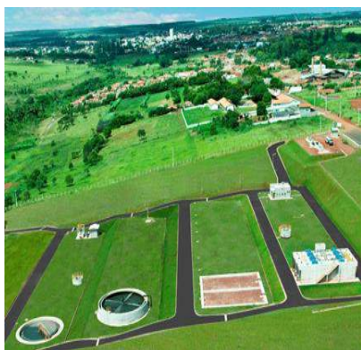
Foto: Vista aérea da ETE
