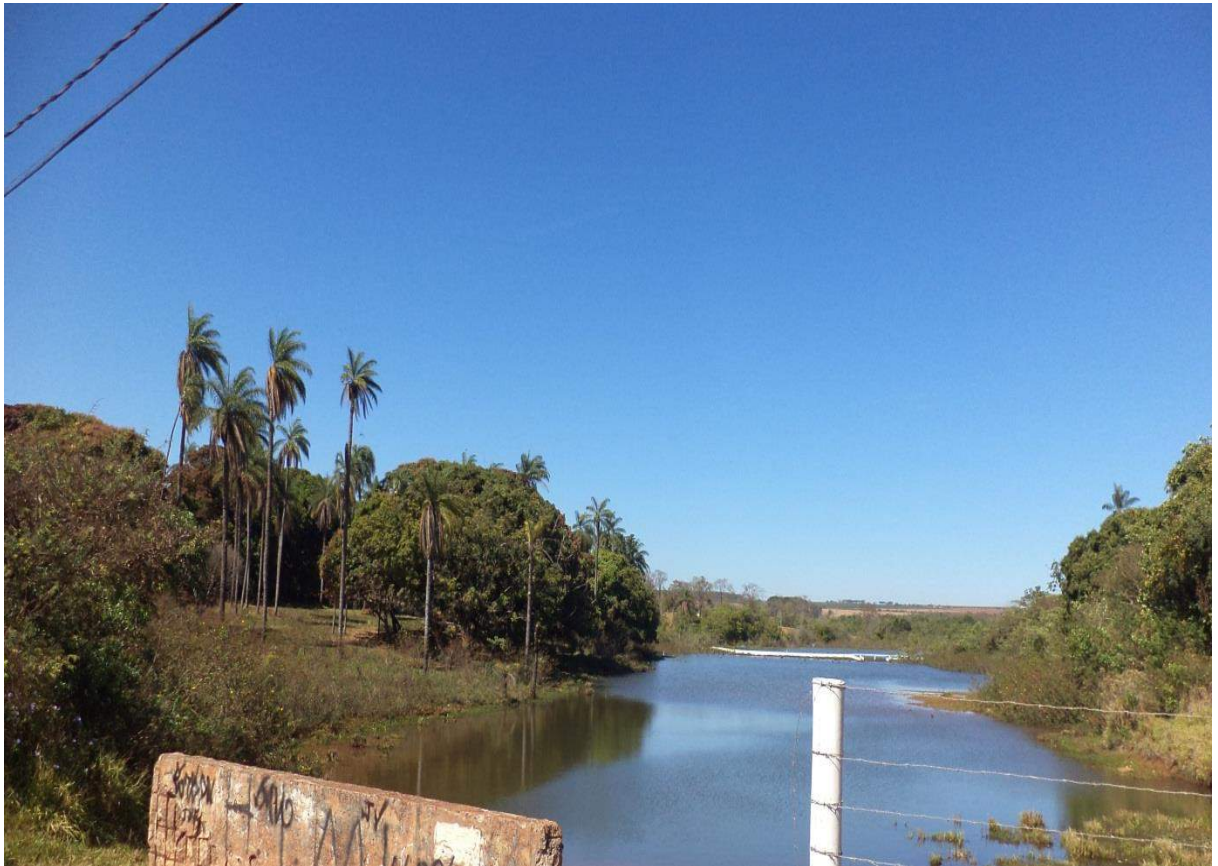
Foto: Pequeno reservatório de contenção de cheia no Córrego Mumbuca.
