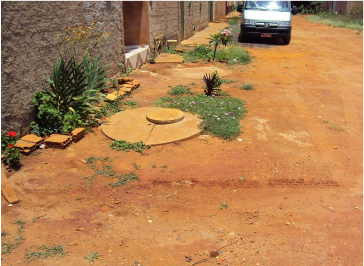
Foto: Fossa Negra em logradouro público no Bairro Mansões Fidalgo.
