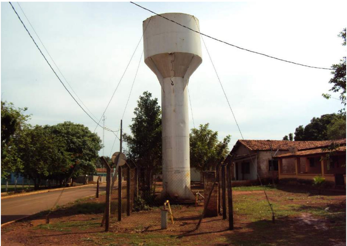
Foto: Reservatório do Povoado dos Gonçalves.
