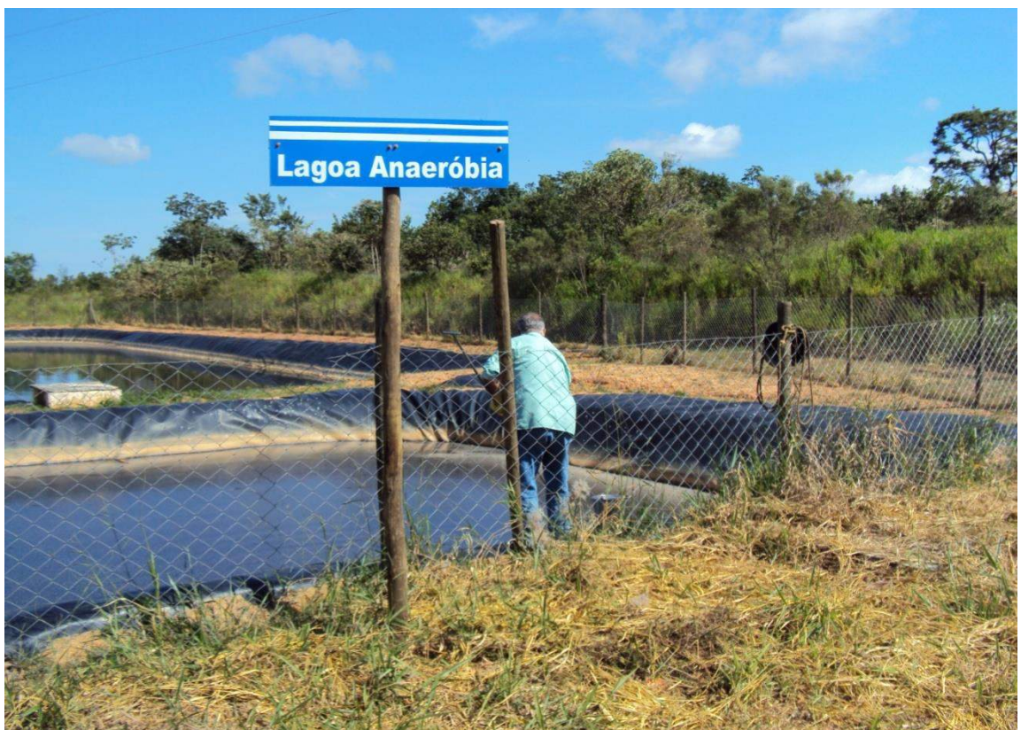
Foto: Lagoa Anaeróbica do Aterro Sanitário
