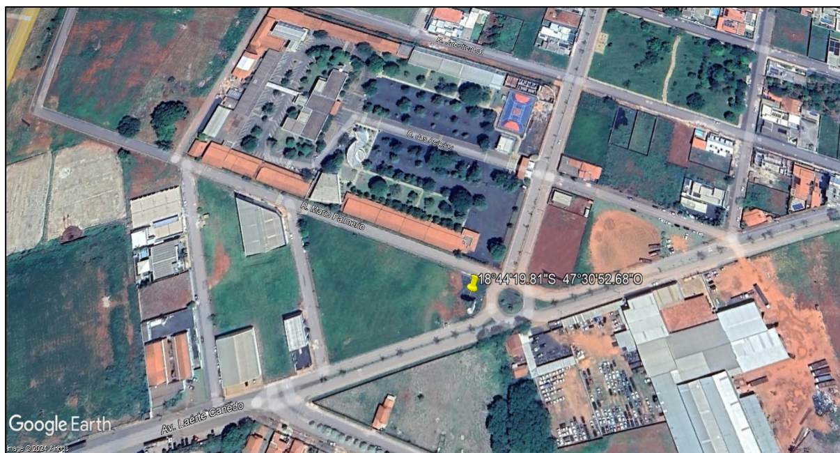
Figura 4: Local estimado para perfuração do poço bairro Zeny
